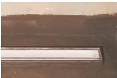
Prefabrikovaný sprchový odtok se pokládá dle návodu výrobce do konstrukce v podkladu. Na očištěnou odtokovou přírubu a skloněnou hranu podkladu naneseme těsnící mikromaltu IZOHAN EKO 2K. Po uplynut 48 hod. Lze dotáhnout všechny spoje a nastavitelné části dního sifonu. Pokud budeme ve finále používat ozdobné odpadní rošty/mřížky (nerezové nebo z PVC), pak se kolem nich musí použít podlahový hydroizolační límec
