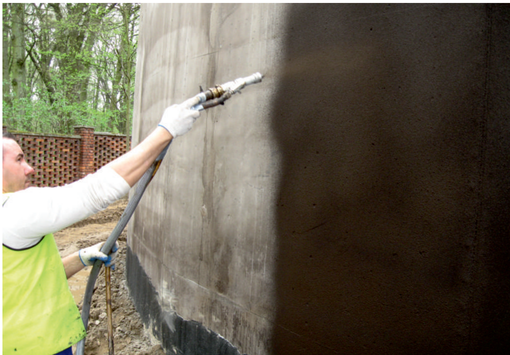
BITUMENOVÁ IZOLACE PROVÁDĚNÁ NÁSTŘIKEM
