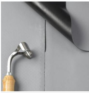
Během montáže membrány o tloušťce 1,5 mm a 2,0 mm doporučujeme přeložení hrany membrány v místech křížových a příčných spojů. Přeložený fragment membrány musí být delší než je šířka celého horkovzdušného svaru.
