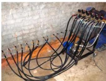
Provádí se pomalým vtlačováním injektážního preparátu za konstantního tlaku pomocí vysokotlakých injektážních pakrů, injektážních svorníků nebo injektážních jehel umístěných v ústí vývrtů. Tlaková injektáž je mnohem účinnější než gravitační, takže ji lze doporučit také ve zcela mokrému zdivu (doporučuje se pouze vysušení pásu zdiva v místě vývrtů). Tato metoda nám umožňuje průběžné sledování injektáže a injektážní vývrtu lze vrtat dokonce vodorovně.
