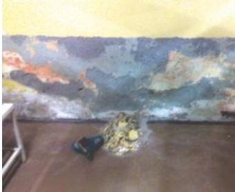
Proces odplísňení je nutno zahájit důkladným čištěním podkladu. V případě nepatrného zasažení plísni, je třeba pouze odstranit navlhčenou tapetu ze zdi. Pokud je zasažení rozsáhlejší, musíme odsekat vlhkou omítku minimálně 80 cm do nezasažené plochy. Odsekanou omítku je třeba okamžitě odstranit z místnosti. Další fází je vysušení vlhké zdi pomocí horkého vzduchu a vhodného větrání. Mnohdy se stává, že vnitřní vlhkost bytu je zapříčiněná nedostatečnou termoizolací (vznik tepelných mostů).
