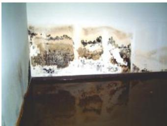
Na čisté a suché zdivo, zbavené prachu a nečistot lze aplikovat preparát **IZOHAN grzybostop (mykostop - akutní fungicidní prostředek)**. Nanášení preparátu lze provádět pomocí štěnce nebo nástříkem. Používáme metodu tyndalizace: minimálně 3 x nanášíme vždy s přestávkou 24 hodin. Mnohočetná aplikace zabrání vzniku plísňových výkvětů.
