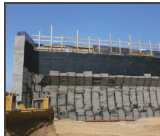
ROLOVANÁ IZOLACE MOSTNÍCH OPĚŘ
