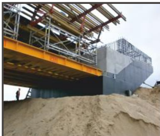
POVLAKOVÁ IZOLACE MOSTNÍCH OPĚŘ
